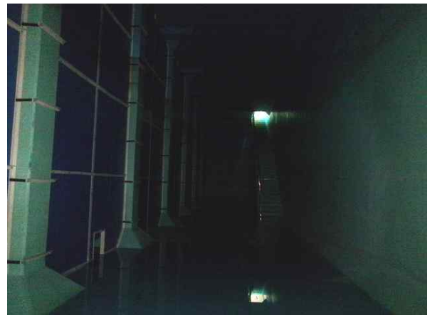
배수지 2지 내부 전경
