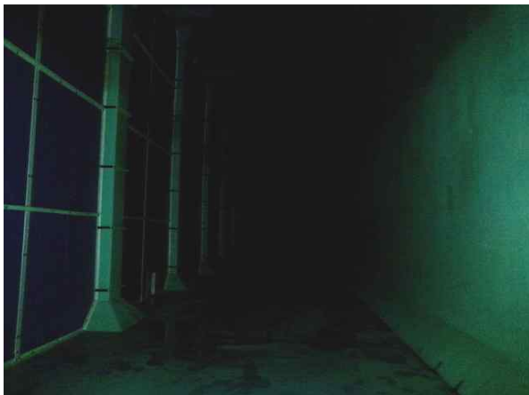
배수지 1지 내부 전경
