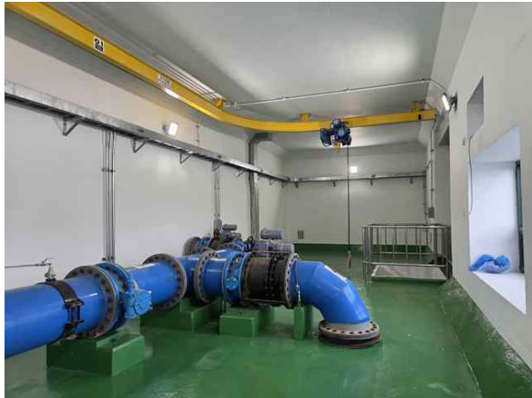
유입밸브실 내부 전경
