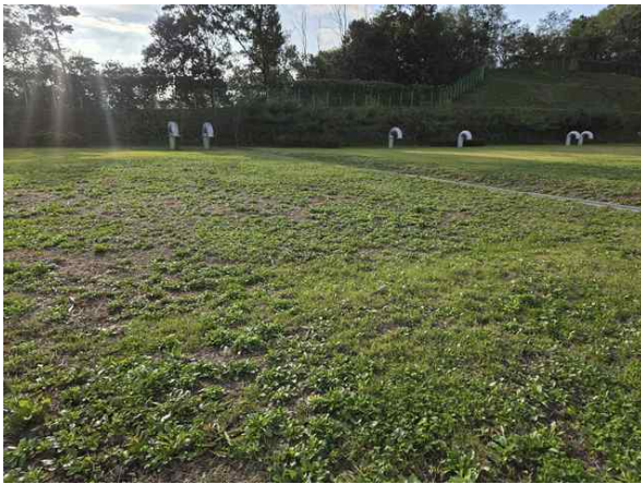
배수지 상부 현황
